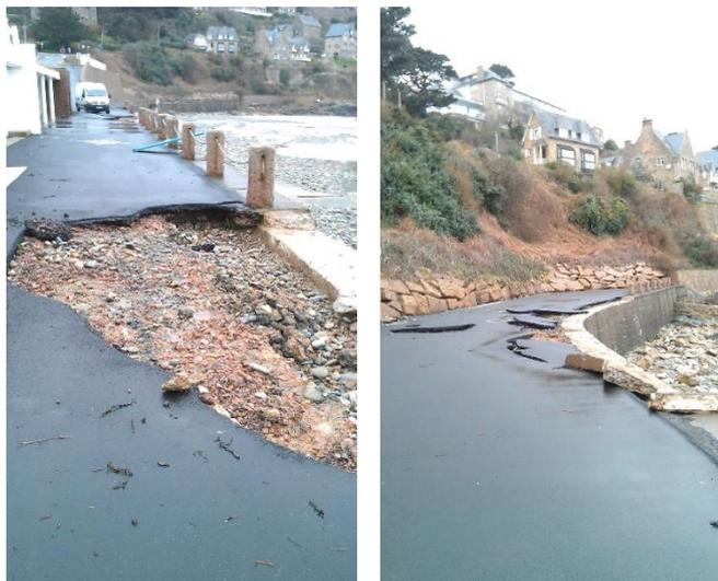
Fig. 83. Dégâts sur la digue de Trestrignel dus à la tempête du 3 mars 2014
