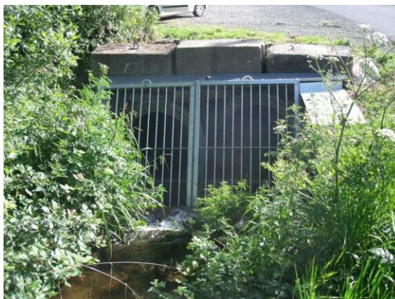
Fig. 61. Grilles inclinées pour limiter l'obstruction des buses
