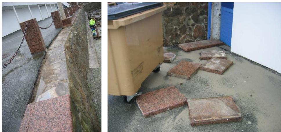
Fig. 79. Dégâts sur le dallage devant le centre nautique de Trestraou (tempête du 10 mars 2008)
