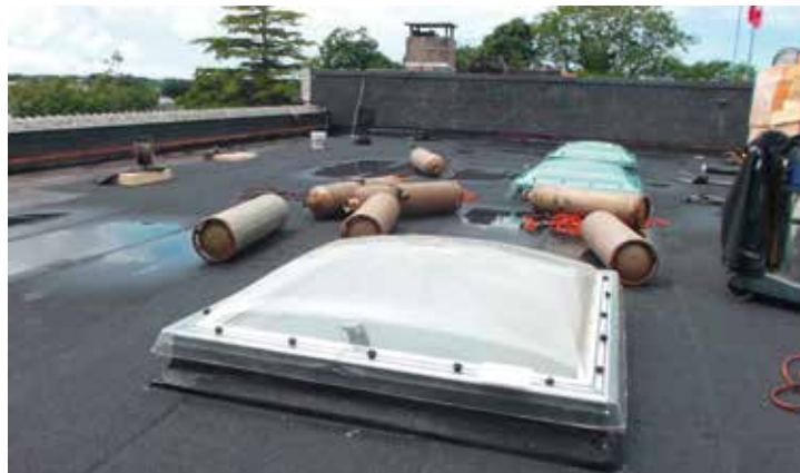
Réfection du toit terrasse de la Mairie
