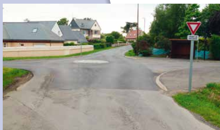
Travaux en cours mise en sécurité Hauts de Kernu
