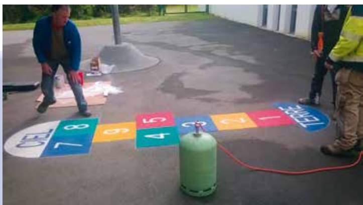
Jeu de la Marelle en cours d'installation à l'Ecole Maternelle
