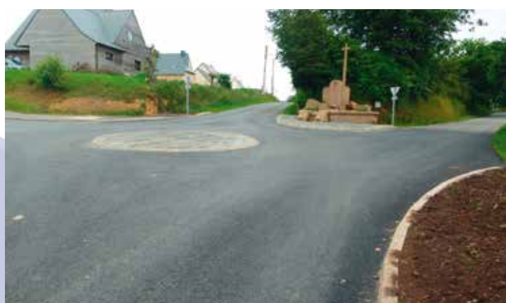
Travaux en cours mise en sécurité au Guilors
