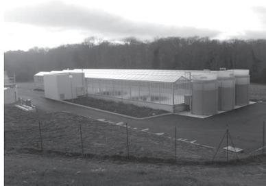
entièrement clos et couvert de verre « sécurit ». A l'intérieur arrivent les boues préalablement centrifugées à environ 30% de siccité. A ce stade, leur aspect équivaut à celui d'une terre
