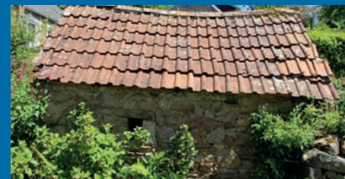
Une dépendance de ferme couverte avec des faitières et tuiles « anglaises » double romane
