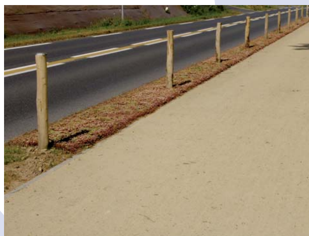
Le revêtement en tapis de sédum sur la bande verte de séparation.
