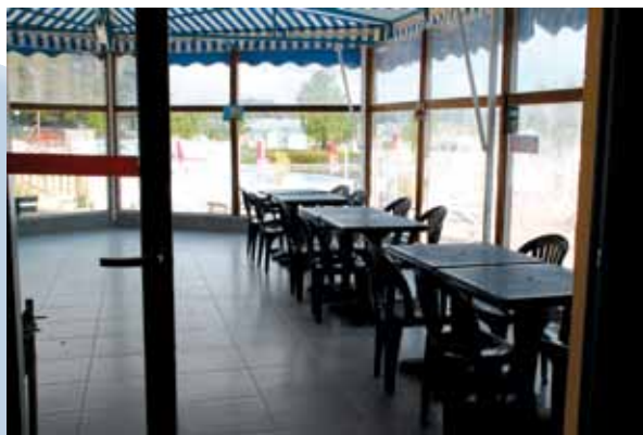
Carrelage de la salle de restauration
