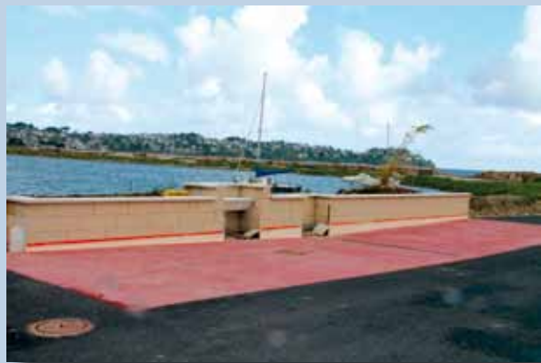
aire de vidange camping-car en cours de finition
