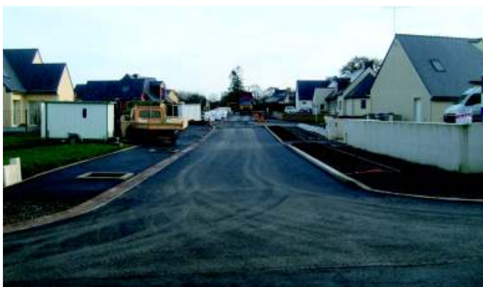
Résidence Kerespertz 1 (Travaux de voirie terminés).
